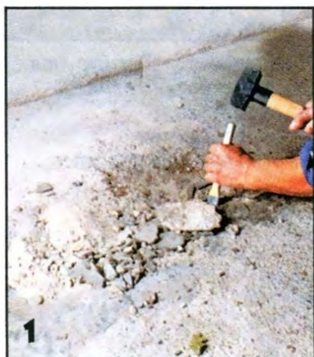
1 Для нового пола гаража нужна прочная основа. Отслоившиеся куски бетонного покрытия удаляют с помощью долота и молотка.
