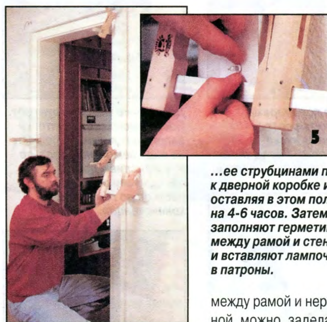
4 Вместо дюбелей и шурупов раму можно прикрепить на герметике. Нанеся герметик на тыльную сторону рамы,...
