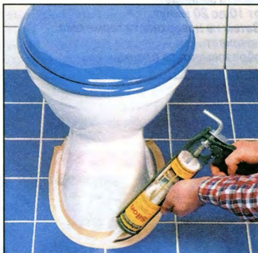
Шов между унитазом и полом заполняют сантехническим силиконом. Края шва оклеивают лентой.
