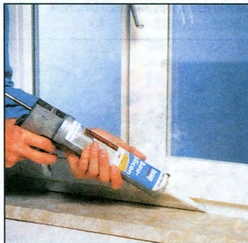
Через стык оконной рамы со стеной не должен проникать ни дождь, ни холод. Кроме того, герметик хорошо компенсирует температурные изменения размеров оконного проема в стене и установленной в нем рамы.
