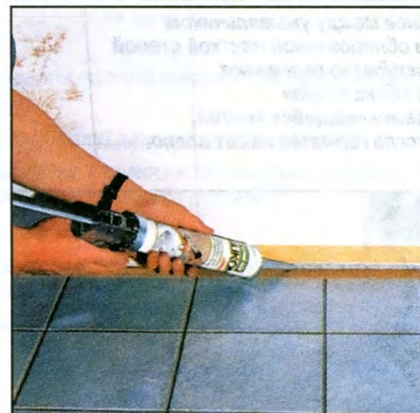
Швы между стеной и полом во влажных помещениях и на кухне следует уплотнять, даже если потом они будут укрыты плинтусами.
