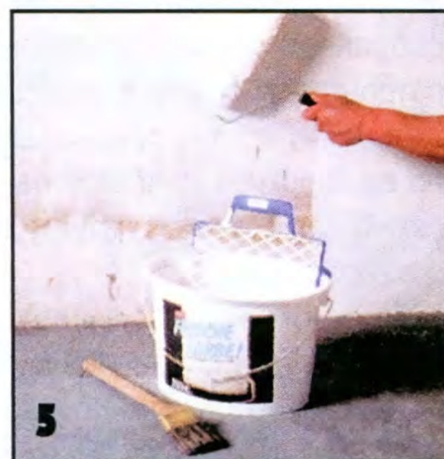
5 Пока раствор схватывается, можно покрасить стены. Затем пол еще раз увлажняют с помощью жесткой щетки или веника.
