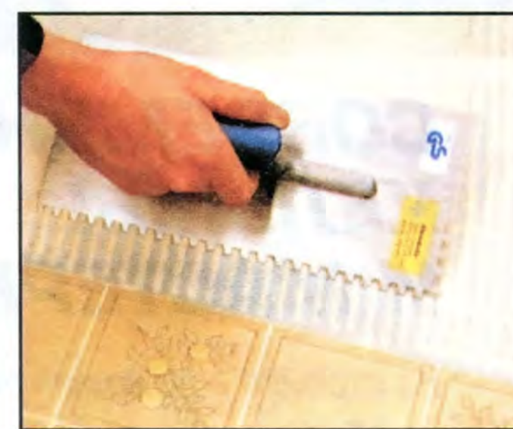
Зубчатый шпатель позволяет равномерно распределить клей.
