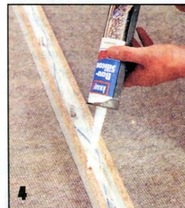
4 Вместо дюбелей и шурупов раму можно прикрепить на герметике. Нанеся герметик на тыльную сторону рамы,...
