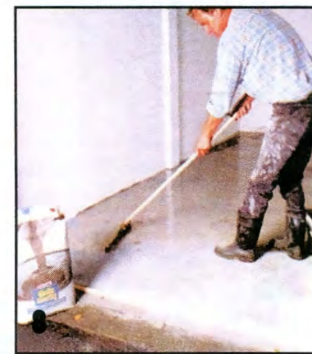
Распределяют раствор равномерно по полу резиновым шпателем, стараясь не оставлять перепадов между отдельными участками.
