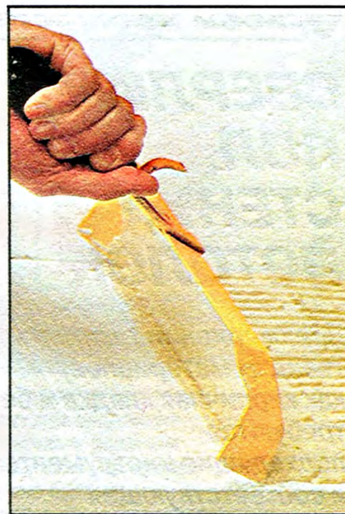
Так работают мастерком для газобетона.
