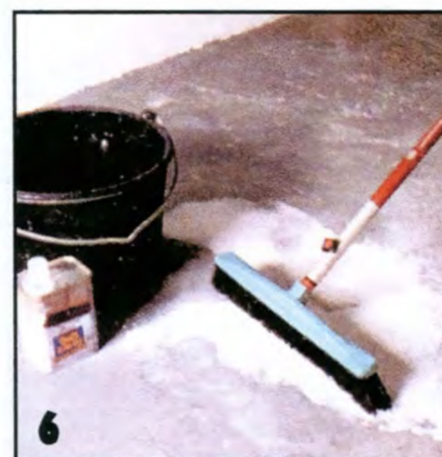
6 Пористую и гигроскопичную основу надо сначала загрунтовать. Это повысит адгезию шпатлевки с основой.
